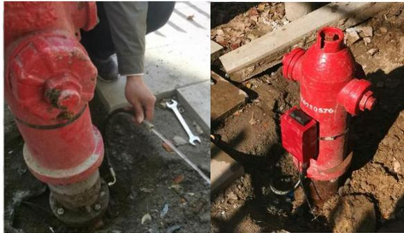
3.2.8 将航空插头接入消火栓传感器并旋紧到位，等待 30 秒后打开消火栓上端开关放几十秒水后关断，等待 2 分钟后查看平台数据，若水压，叶轮转速均无误，即恢复现场，完成施工。
