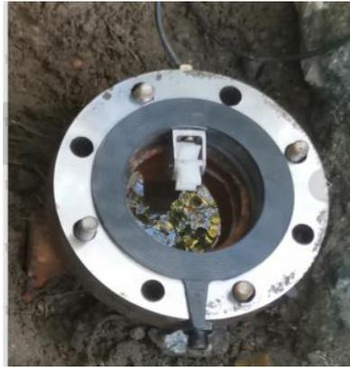
3.2.5、装配法兰盘上的高压水管：装配时需加装密封圈，保证螺丝口旋紧密封。
